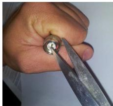
**15.-** Enrosacar con cuidado el conector de la antena y colocar la cinta auto soldable y un precinto, que les ha sido provista con la placa. (puede colocar un candado si dispone de el)
