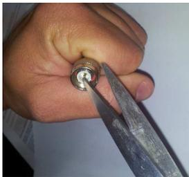
**11.a.-** Enrosacar con cuidado el conector de la antena y colocar la cinta auto soldable y un precinto, que les ha sido provisto con la placa. Colocar Masilla.
